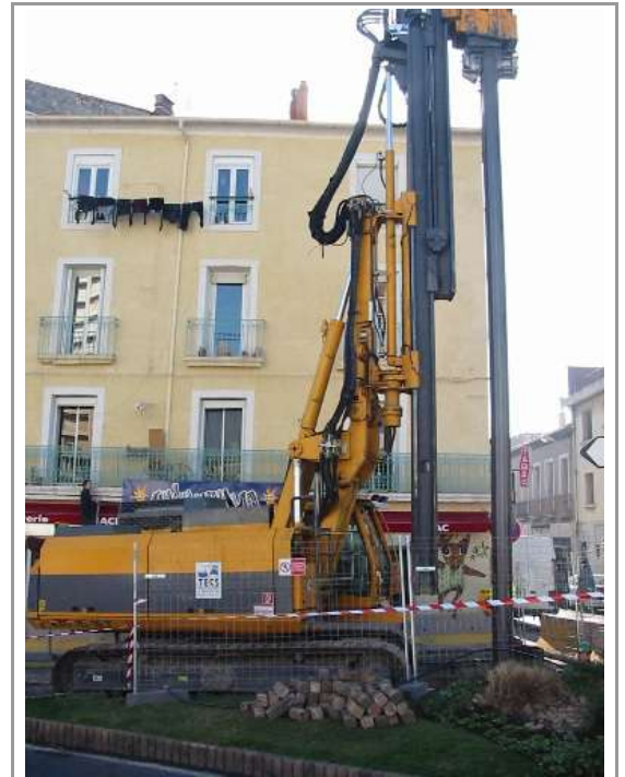
Mesure de vibrations en milieu urbain
